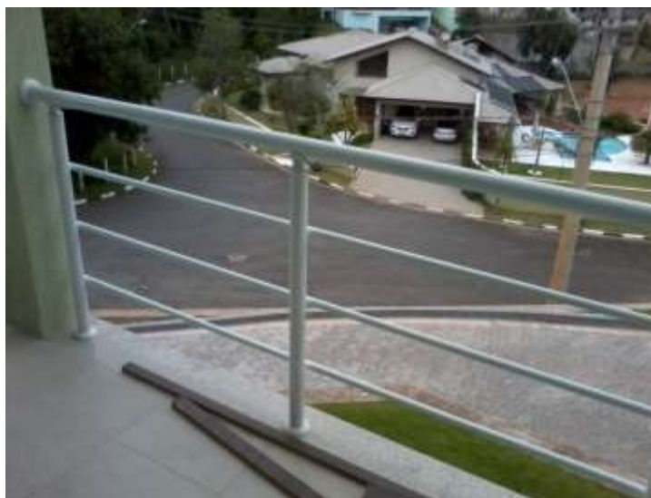
Figura 11: Guarda Corpo de aço – Referência.
